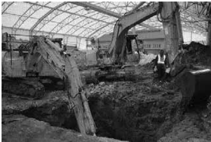
Рис. 8: Внутренняя обстановка в укрытии в ходе экскавационных работ Источник: Федеральное правительство Австралии (2013)
