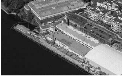
Рис. 7: Восстановительные работы с использованием укрытия для устранения неприятного запаха и последовательным процессом очистки Источник: Федеральное правительство Австралии (2013)
