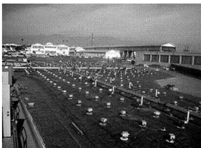
Рисунок 12: Полномасштабная термальная десорбция in situ на участке заражения органическими соединениями в США Источник: Merly и Hube (2014).
