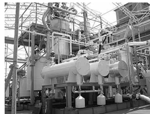
Рисунок 16: Установка катализируемого основанием разложения в Сполана Наратовиче, Чешская Республика, на стадии строительства.
